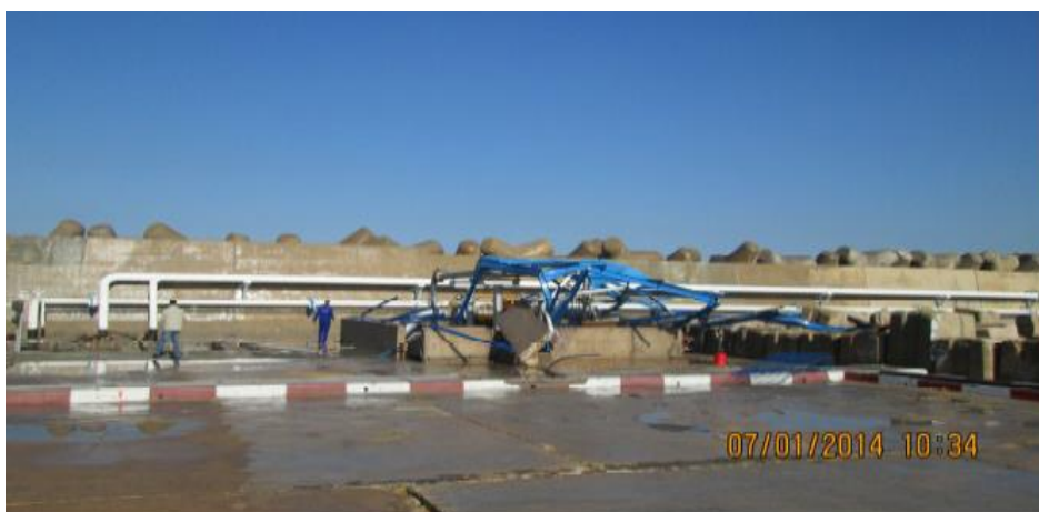
Figure 17: Arrachement des grillages de protection et endommagement du mât de feu de guidage
