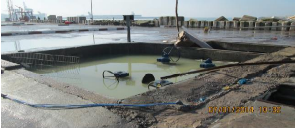
Figure 18: Enlèvement des dalles des caniveaux
