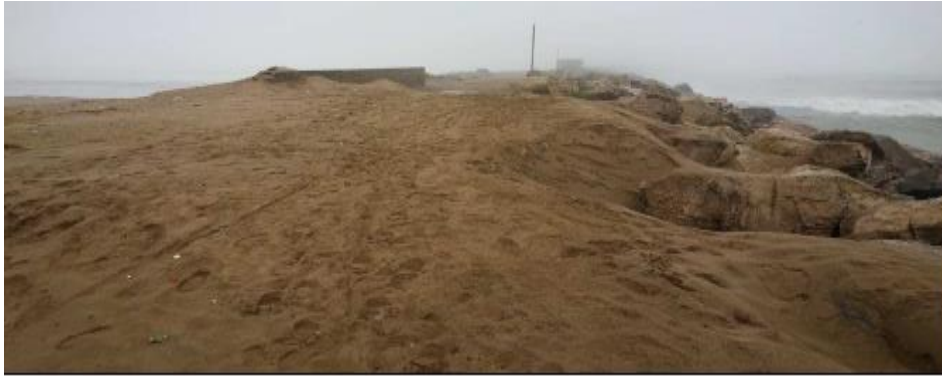
Figure 16: Ensablement provenant de la plage vers le chenal
