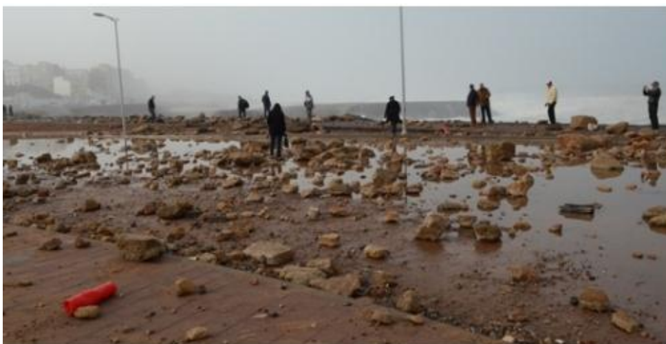
Figure 24 : Route côtière Sidi Moussa à Salé après la houle
