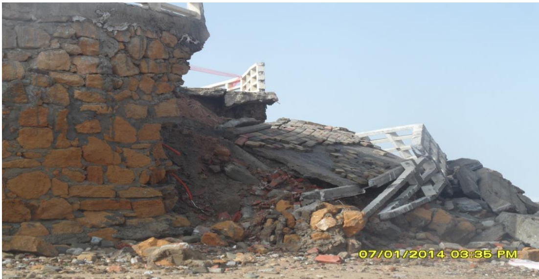
Figure 25 : Mur du complexe Yasmina partiellement détruit
