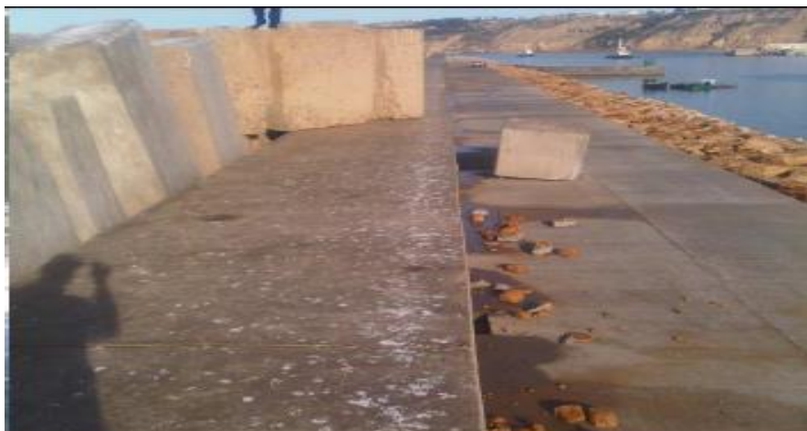
Figure 20: Déplacement de tétrapodes
