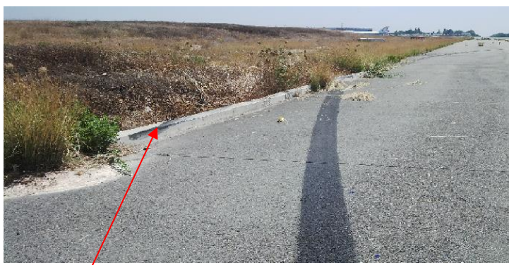
Trottoir sur le bord de l'accotement de la bretelle M
