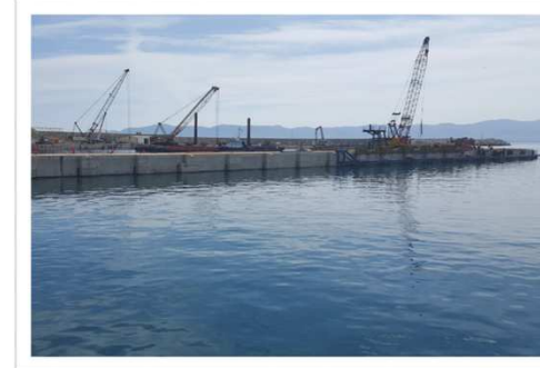
Construction de la digue Secondaire
