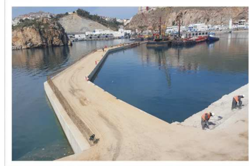
Construction de la digue Principale
