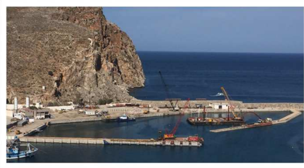
Vue globale du chantier
