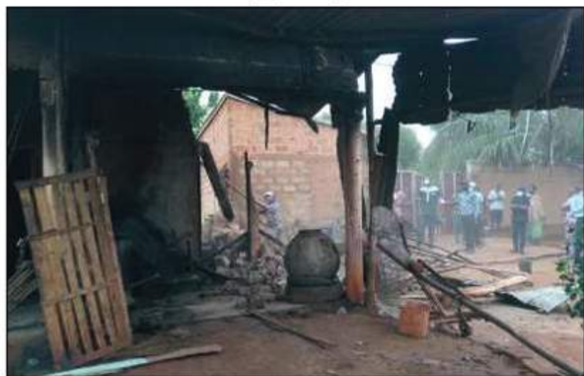
Des dégâts enregistrés
