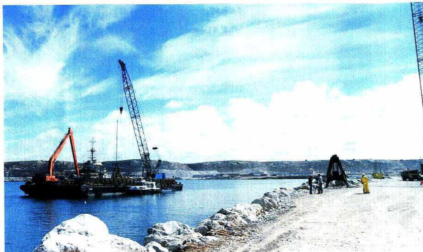
Le nouveau port de Safi vise à renforcer la connectivité maritime nationale.
